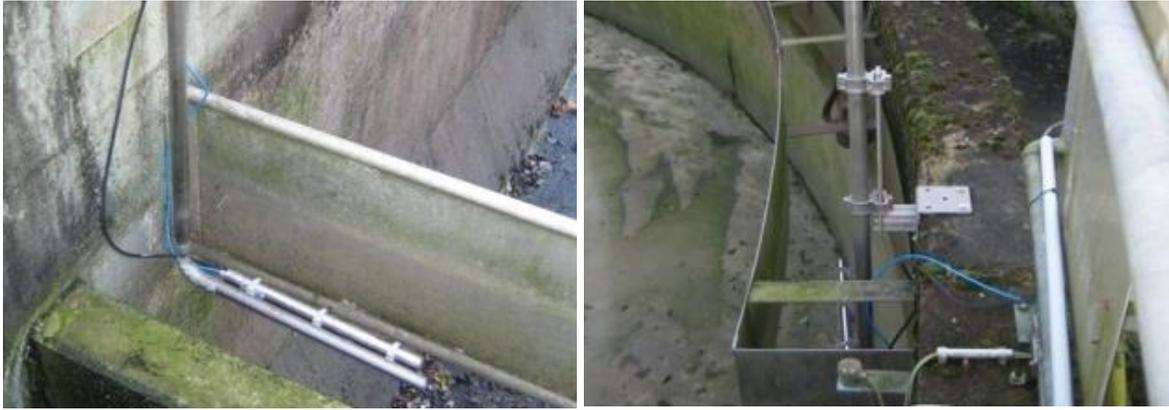
**Abbildung 42: Positionierung an Rechteckbecken zwischen Klärüberlaufschwelle und Tauchwand (links: Rodt-Müllenbach; rechts Kürten-Sülze)**
