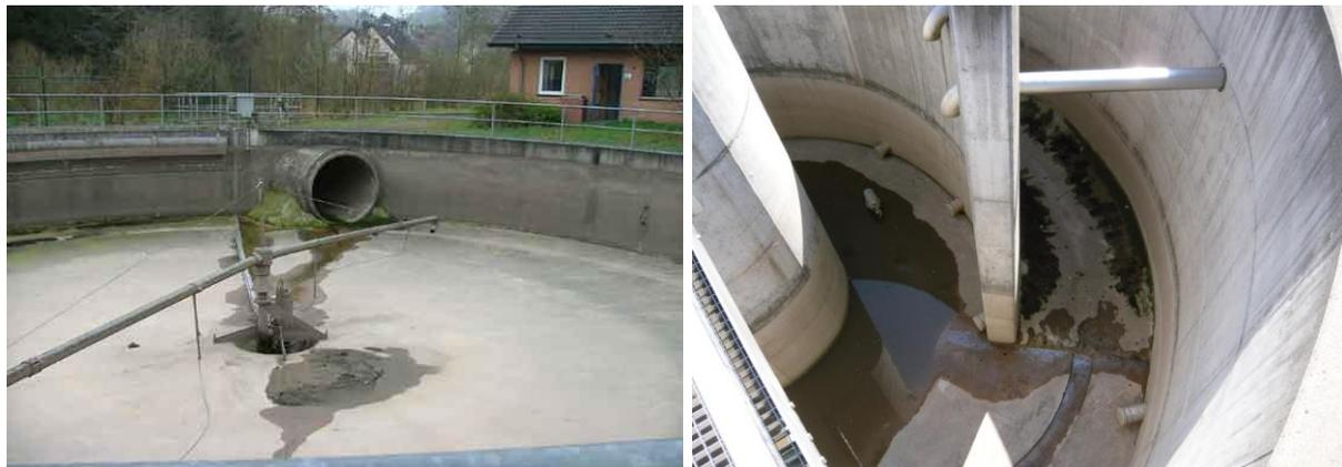
**Abbildung 10: Einlaufsituation an Rundbecken (links: Wirbelschachtbecken; rechts: Zulaufgestaltung mit einem innenliegenden Zulauf in Form einer Strömungsleitwand)**
