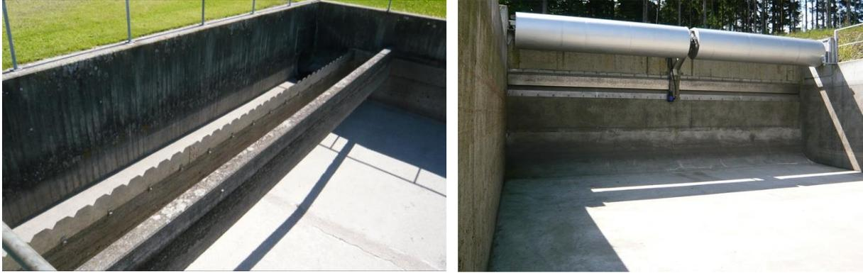
**Abbildung 7: Anordnung von Entlastungsschwellen über die Beckenbreite**
