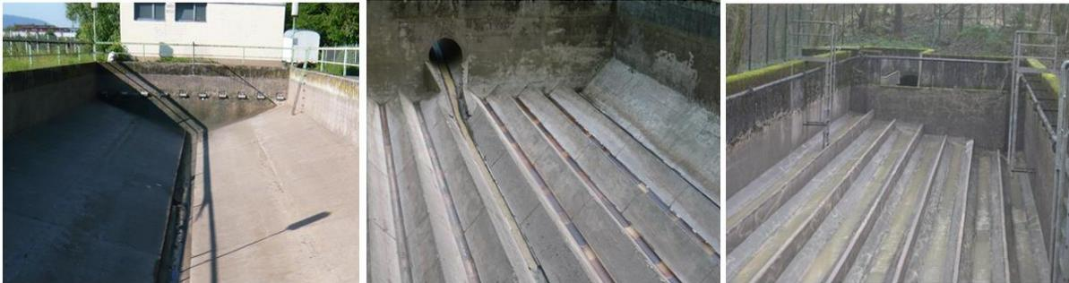
**Abbildung 6: Sonderbauweisen von Sohlengestaltungen (links: Trapezförmige Sohle; mittig: Höckerrinnen; rechts: Schlangengrinnenprofil)**
