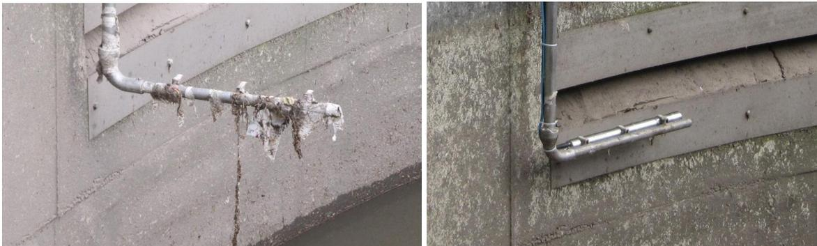
**Abbildung 43: Positionierung der Halterung (links: bei nicht sachgemäßer Positionierung und rechts: nach Empfehlung)**
