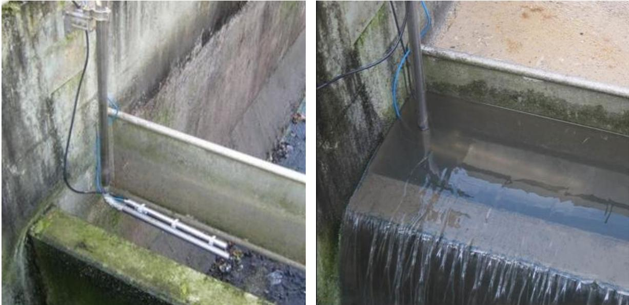
**Abbildung 40: Typische Einbausituation einer UV/VIS-Spektrometersonde am Klärüberlauf**
