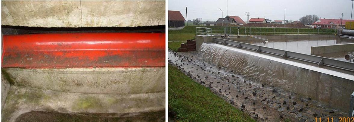
**Abbildung 48: Entlastungsschwellen mit Messprofilen: Vollmar-Messprofil (links), Tragflügelmesswehr nach UFT, Prof. Brombach (rechts, Foto: Withopf)**
