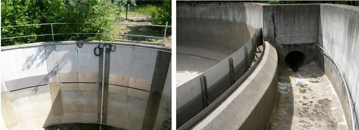
**Abbildung 11: Ausführung von Wehrschwällen bei Rundbecken. Schlitzwehr (links), scharfkantige Wehrschwelle (rechts)**
