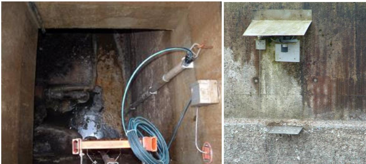
**Abbildung 47: Ausführungsbeispiel – Messung von Beckenfüllständen (Drucksonde, links) und Entlastungshöhen (Ultraschall-Echolot, rechts)**
