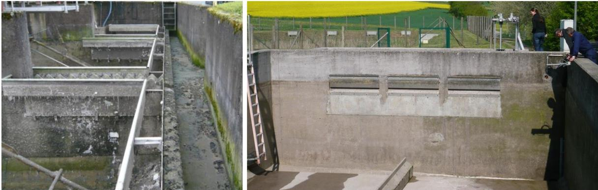
**Abbildung 8: Anordnung von Entlastungsschwellen: länger als die Beckenbreite (links) und kürzer als die Beckenbreite (rechts)**
